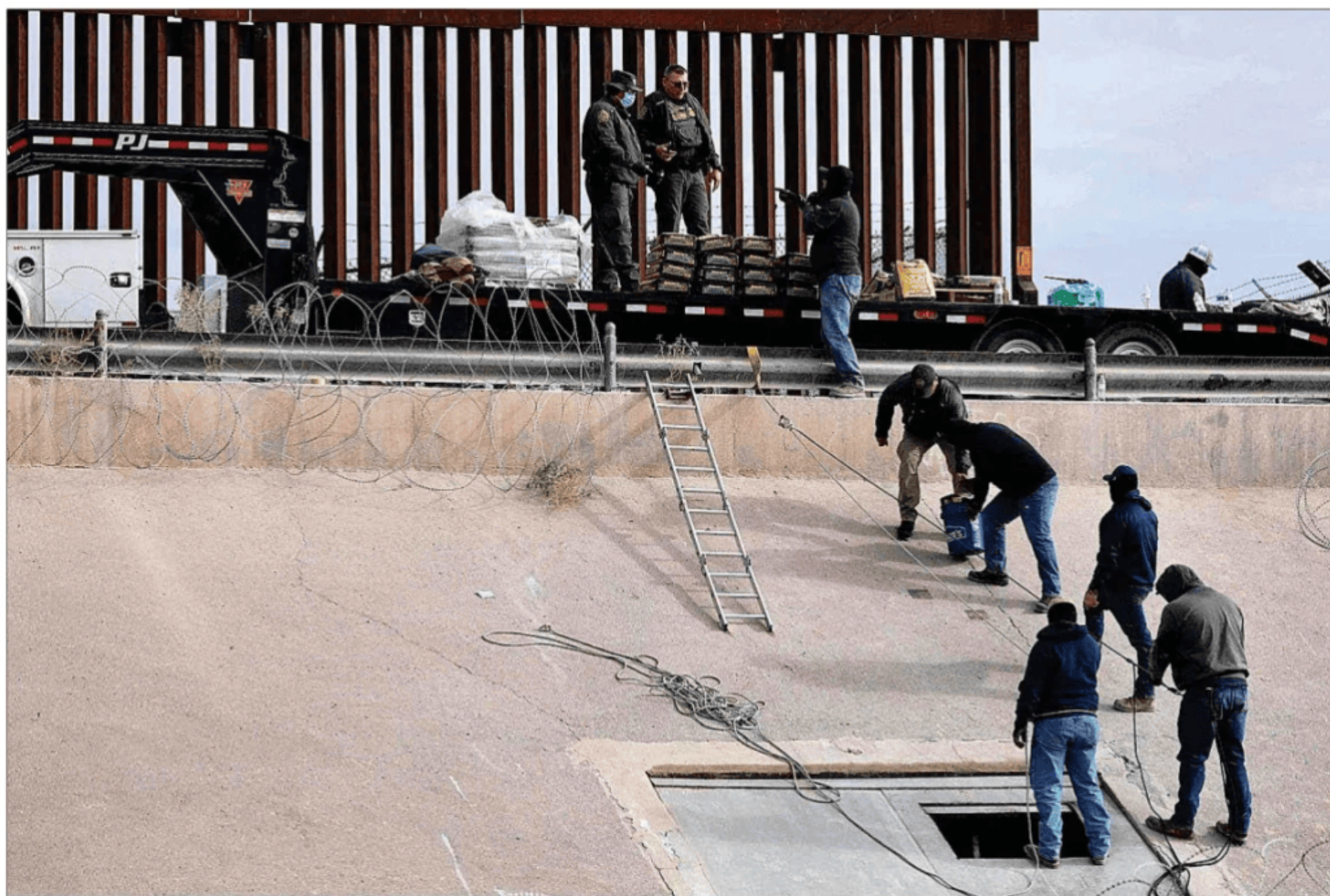
Trabajadores utilizan hormigón para sellar un túnel ilegal con destino a la ciudad fronteriza de El Paso, en Estados Unidos. HERIKA MARTÍNEZ / AFP
